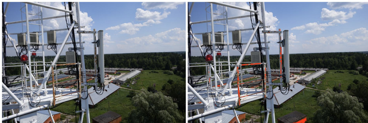
Рис. 7. Результат предсказания модели сегментации коррозии
